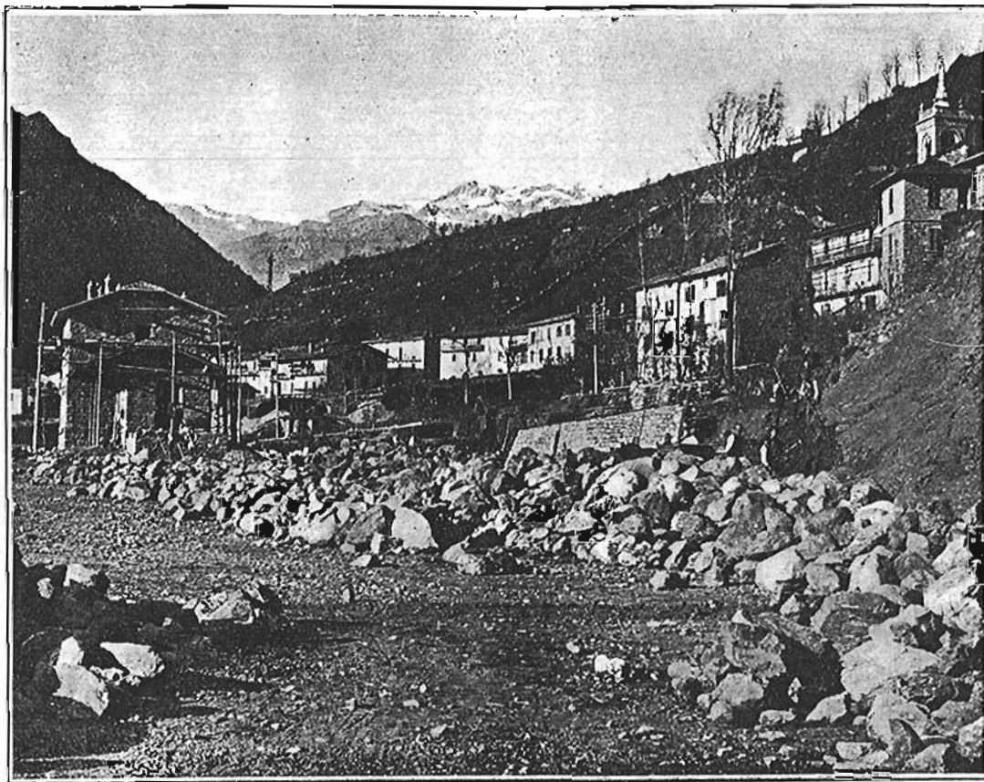
PIAZZALE E STAZIONE DI PIAZZA BREMBANA IN COSTRUZIONE.
