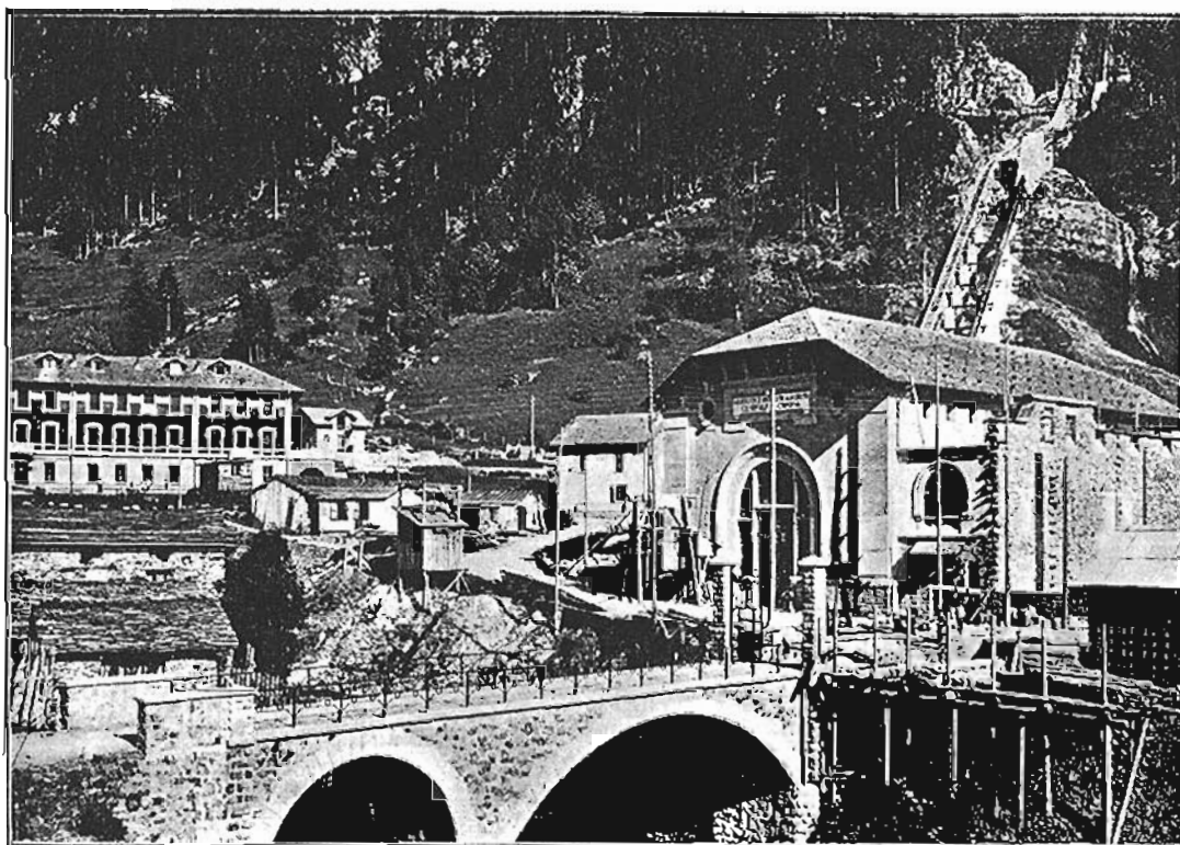
LA CENTRALE DI CARONA ED UN TRATTO DELLA CONDOTTA FORZATA.
