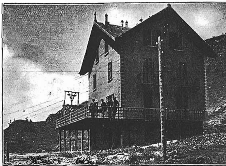
LA CASA PER I GUARDIANI DEI SERBATOI AL PIANO DELLE CASERE (1850 S. M.)
