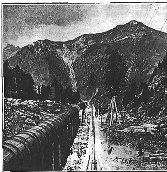
LA TUBAZIONE DI 1800 MM. VISTA DA MONTE.
