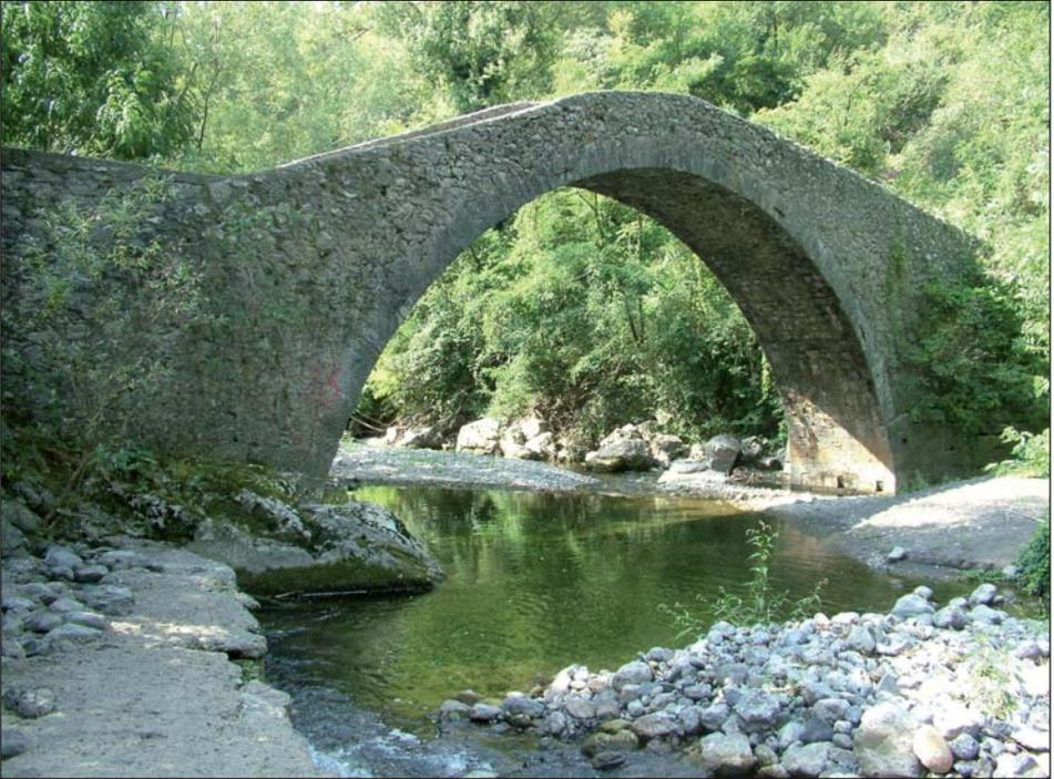
**Insolita vista da nord del ponte di Ubiale a schiena di mulo. Un ponte con il piano di calpestio così ricurvo tecnicamente si dice anche “ponte gobbo”**
